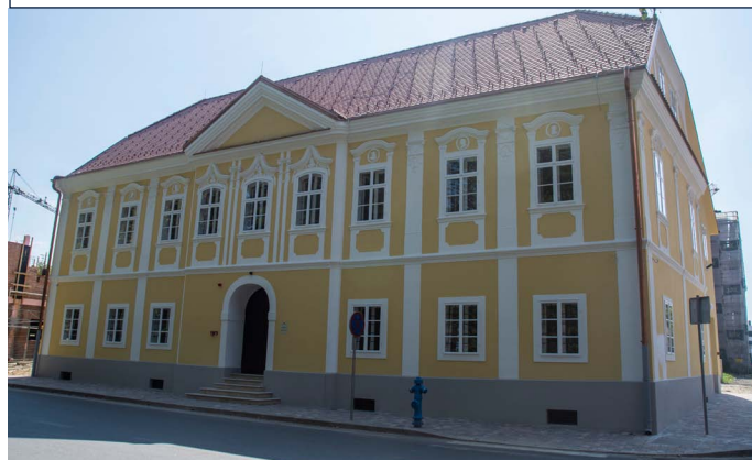
Obnovljena zgrada Ispostave za katastar nekretnina Petrinja
